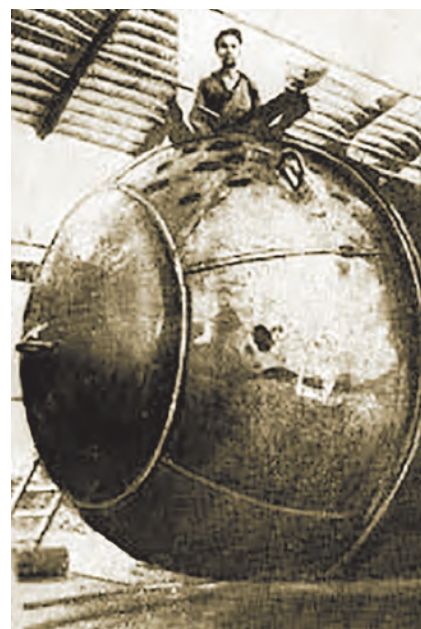
Автоматичне зварювання цистерни
