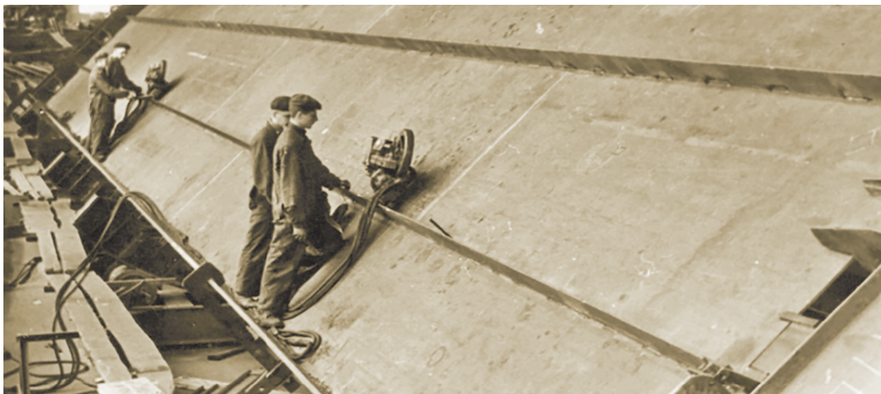
Зварювання балки мостового перекриття на заводі імені Молотова, м. Дніпропетровськ, 1952 р.
