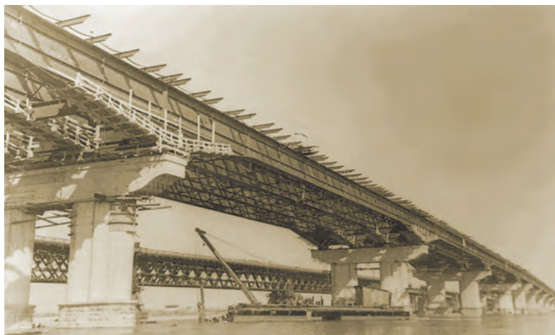
Прогонові будови мосту в період будівництва
