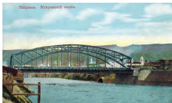
Мухранський міст через р. Кура в м. Тифліс, побудований у 1908 р. за проектом Є.О. Патона
