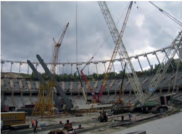
Республіканський стадіон, де було проведено роботи по неруйнівному контролю
