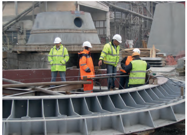
Проведення діагностики зварних з'єднань на Подільському цементному заводі
