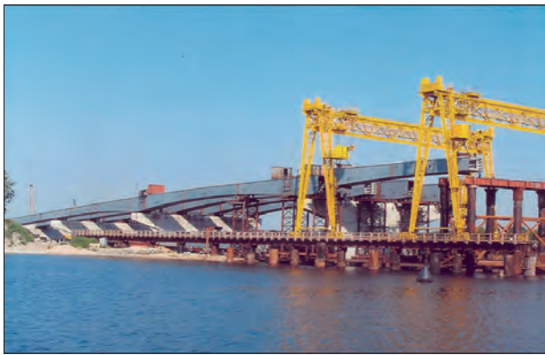
Рис. 5. Будівництво Подільського мостового переходу у м. Києві, арки якого виготовлено зі сталі 06ГБД класу міцності С390
