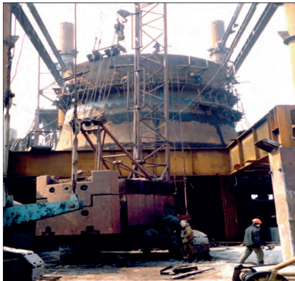
Рис. 7. Ремонт доменної печі ДП-2 на ВАТ «Меткомбінат Азовсталь» з використанням сталевих прокату 06Г2Б класу міцності С440
