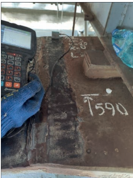
Рис. 6. Приклад контролю стикового шва у верхньому поясі з'єднувальної вставки
