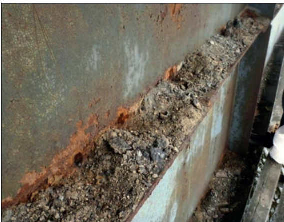
Рис. 9. Ділянка скупчення сміття із зовнішньої сторони крайньої балки п'ятипрогонової споруди
