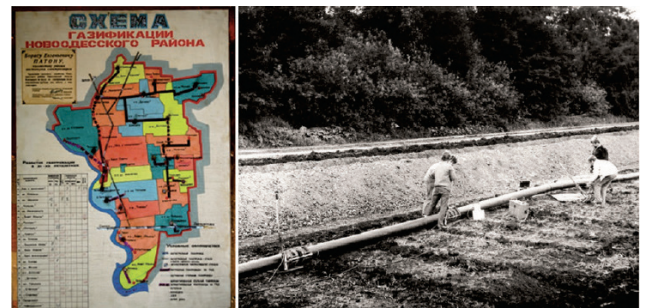
Схема газифікації та будівництво трубопроводу з поліетиленових труб у Новоодеському районі Миколаївської області
