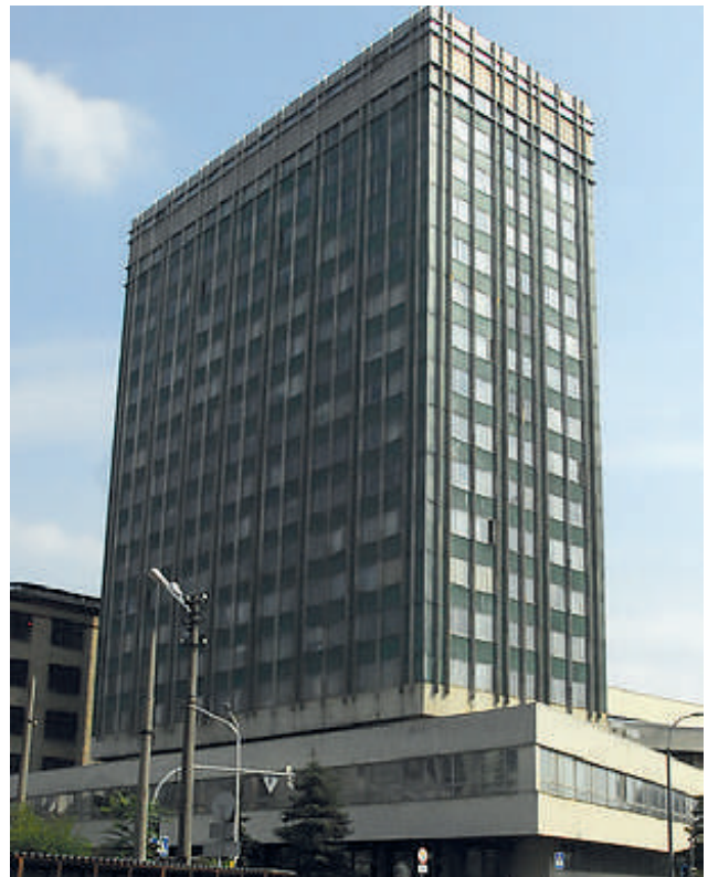
Головний корпус Інституту електрозварювання ім. Є.О. Патона
