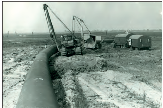
Рис. 10. Застосування технології ЕТЗ трубних багатів в горизонтальній площині
