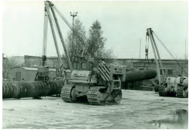
Рис. 7. Випробування технології та обладнання для ЕТЗ труб діаметром 1420 мм на полігоні СКБ «Зварювання нафтогазбуд», м. Бориспіль, 1987 р.
