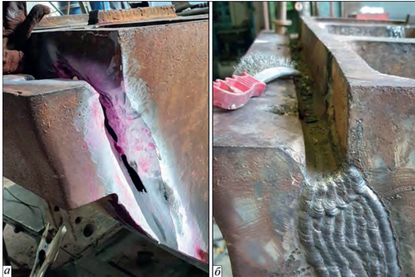
Рис. 5. Загальний вигляд ремонту тріщини № 2 на передній стінці після механічної обробки кромок (а) та після зварювання (б)
