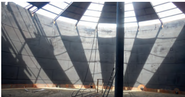
Ремонт клепаного резервуара РВС-5000, який було споруджено у 1895 р.
