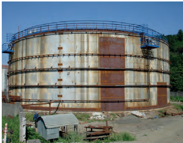
РВС-10000 ( D = 34,2 м, H = 12,0 м) для зберігання нафти після ремонту
