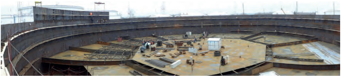
РВСПП-50 000 ( D = 60,7 м, H = 22,0 м) із захисною стінкою: монтаж дводечного плаваючого покриття
