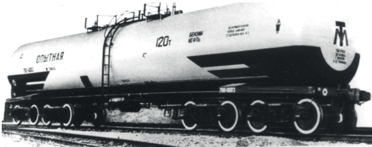
Цистерна з алюмінієвого сплаву, виконана дуговим зварюванням по шару флюсу (технологія Інституту електрозварювання ім. Є.О. Патона)
