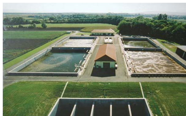
Рис. 16. Двореакторна SBR-очищувальна станція фірми Hydromatic GmbH
