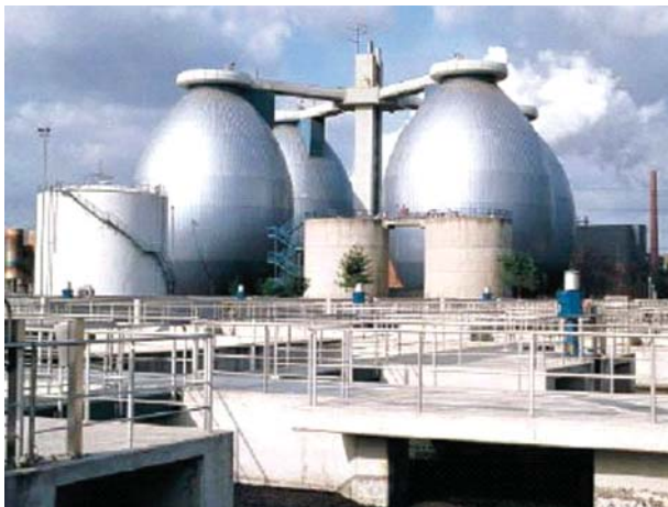
Рис. 3. Яйцеподібні метантенки (септики) в Боттропі (Німеччина)
