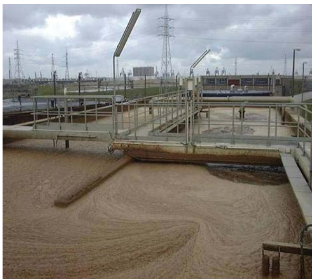
Рис. 15. Біореактор SBR
