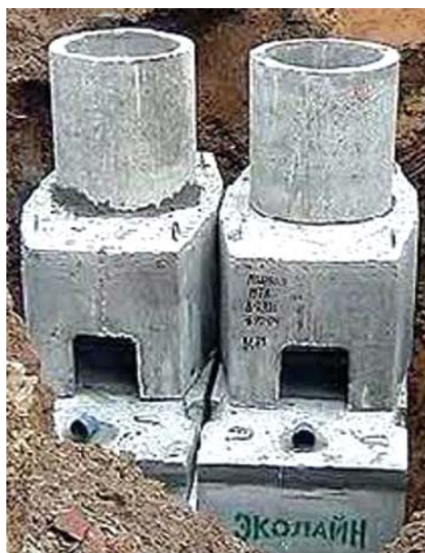
Рис. 1. Примітивний залізобетонний септик
