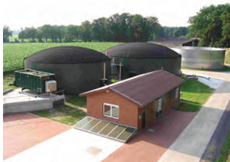
Рис. 8. Загальний вигляд установки Zorg
