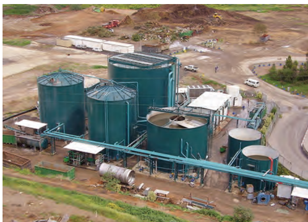
Рис. 14. Будівництво двоступеневої установки з виробництва біогазу поблизу Тель-Авіва (2005 рік)
