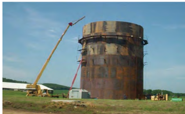
Рис. 6. Біогазовий термофільний біореактор з когенераційною установкою в штаті Вісконсин (США) для обслуговування ферми на 920 голів великої рогатої худоби, 2004 р. [4]
