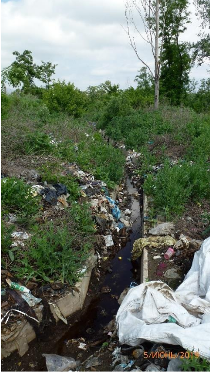
Рис. 5 – Фотографічне зображення бетонного захисного жолобу, що поблизу площадки спостережень № 12 значною мірою засмічений різноманітними побутовими відходами, а станом на 05.06.2019 р. був заповнений водою чорно-коричневого кольору
