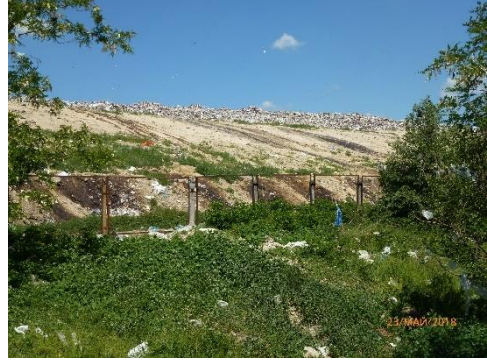
Рис. 4 – Фотографічне зображення району площадки спостережень № 10, на якому темно-коричневим кольором відмічаються місця височування фільтрату з тіла черги «А» полігона № 5
