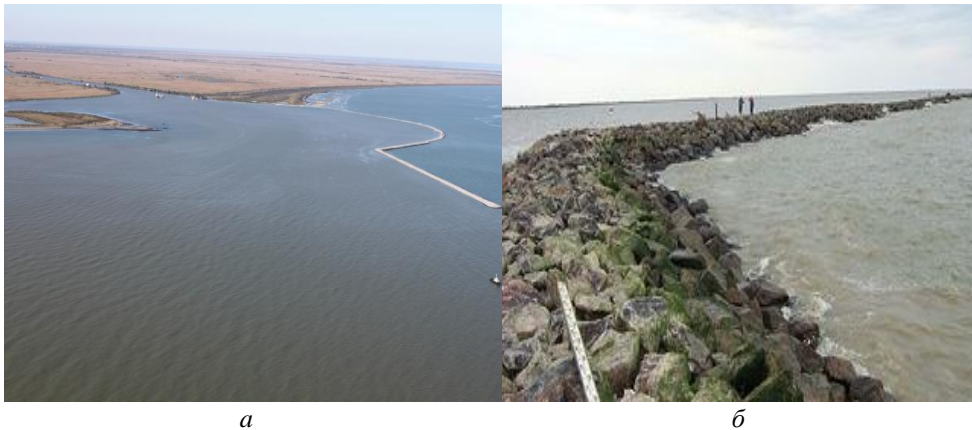
Рис. 1 – Загальний вигляд огороджувальної дамби (а) та фрагмент її кам'яної насипки (б)
