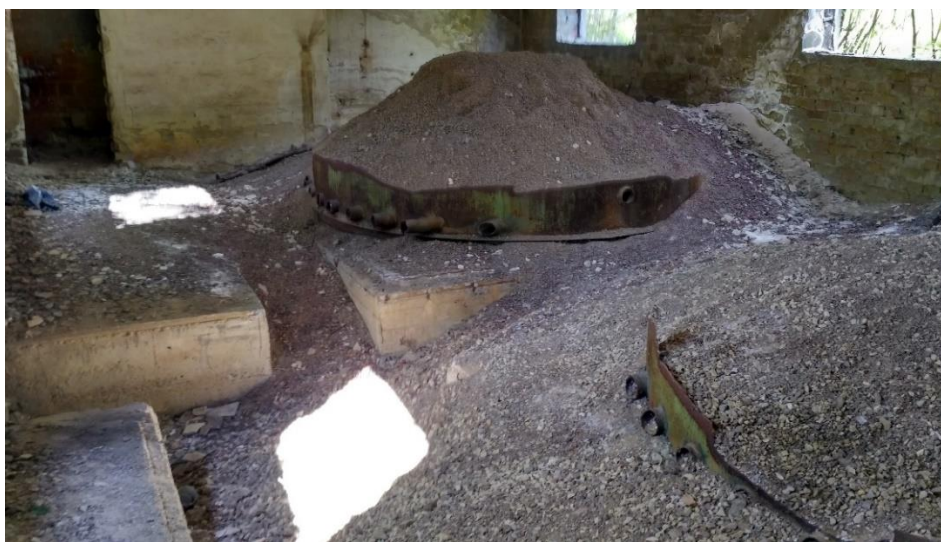
Рис. 2 – Загальний вигляд піщано-гравійних фільтрів
