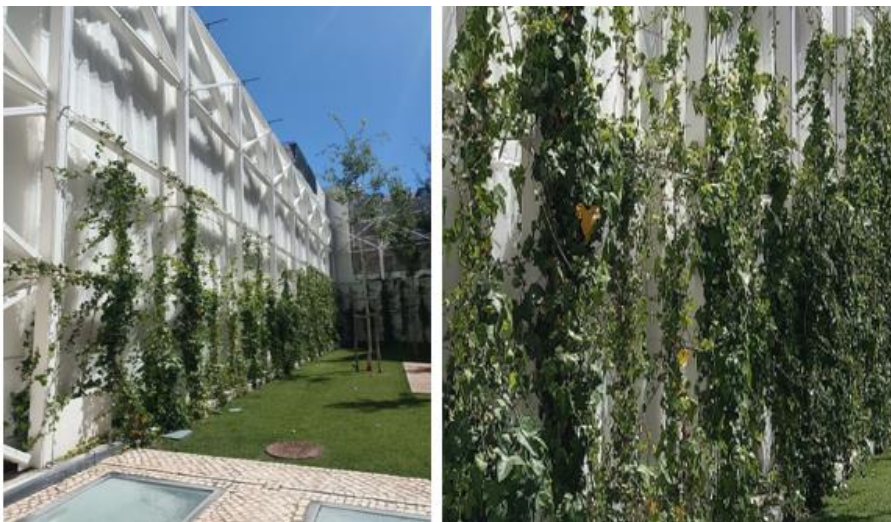
Рис. 3. Вертикальне озеленення на фасаді будівлі в Лісабоні як приклад елемента BGI для пом'якшення міського мікроклімату (авторська світлина)
