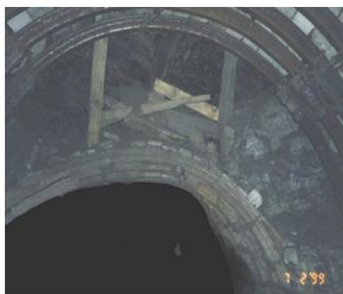
Рис. 9. Характерное состояние полевого магистрального штрека в условиях шахты им. Героев Космоса ПАО «ДТЭК Павлоградуголь»
