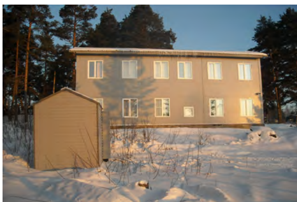
Рис. 1. Сейсмапавильон и здание администрации Ботанического сада ПетрГУ
