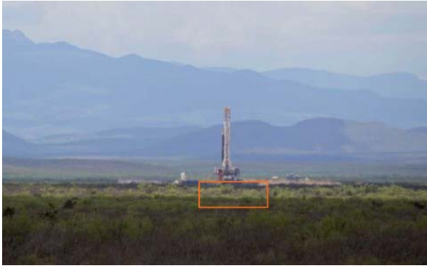
Рис. 31. Буровая установка компании Apache в Западном Техасе, США
