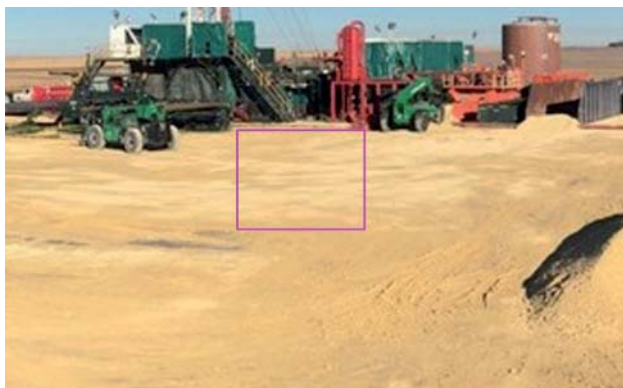
Рис. 4. Участок бурения скважины в США [41]
