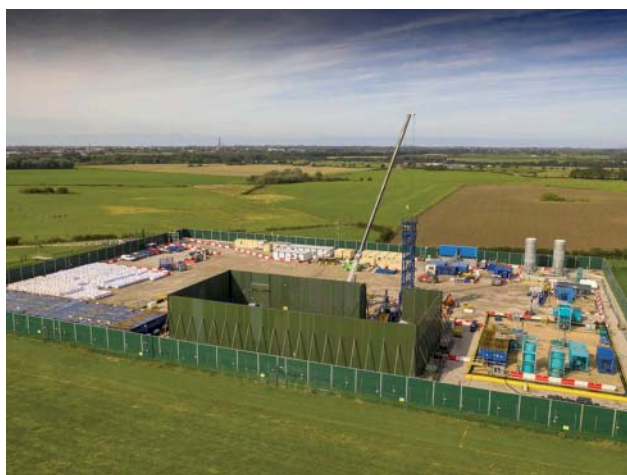
Рис. 7. Фотоснимок скважины на участке Preston New Road (Lancashire, England) [23]
