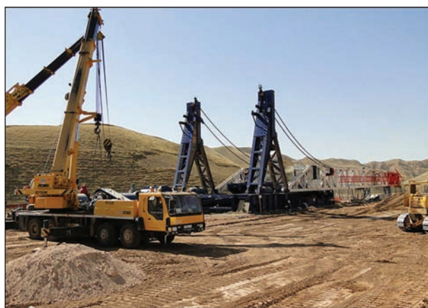
Рис. 15. Площадка монтажа скважины, пробуренной компанией «Газпром» в Таджикистане [10]
