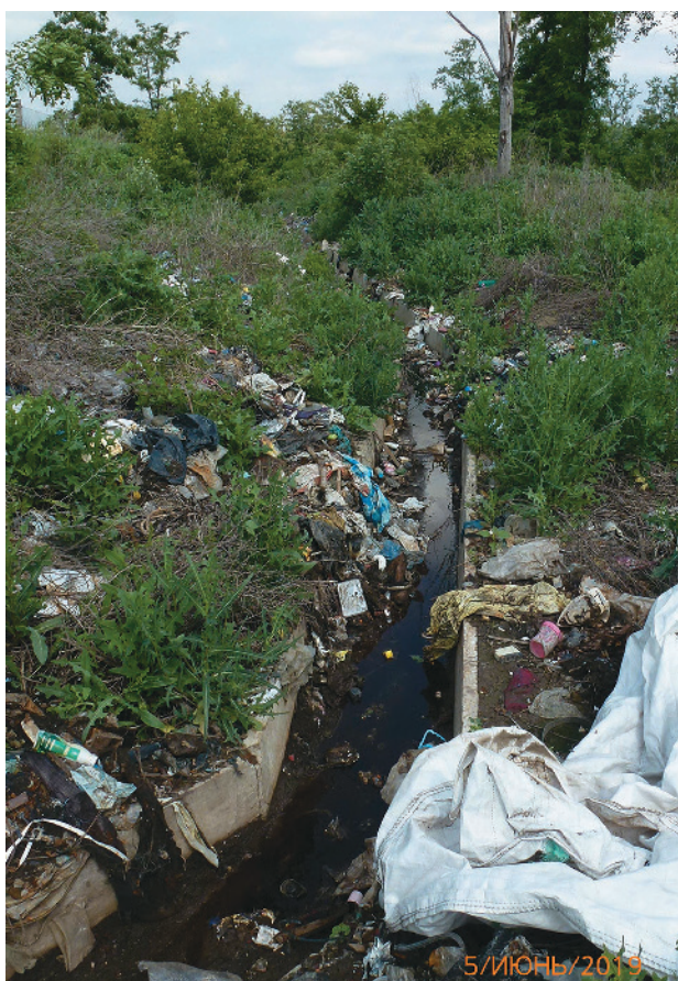
Рис. 15. Фотографічне зображення бетонного захисного жолобу, що поблизу площадки спостережень № 12 значною мірою засмічений різноманітними побутовими відходами і заповнений водою чорно-коричневого кольору
