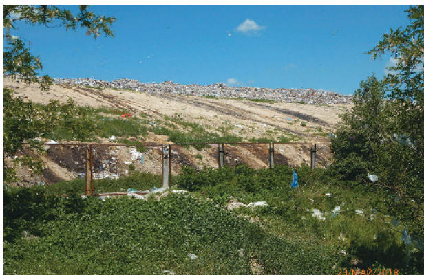
Рис. 13. Фотографічне зображення району площадки спостережень № 10, на якому спостерігають місця височування і стікання фільтрату (темно-коричневий колір) на «тілі» черги «А» полігона № 5
