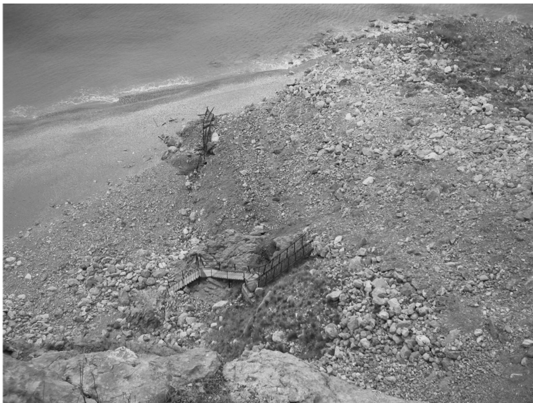
Рис. 3. Языковая часть оползня № 1648 после его катастрофической активизации
