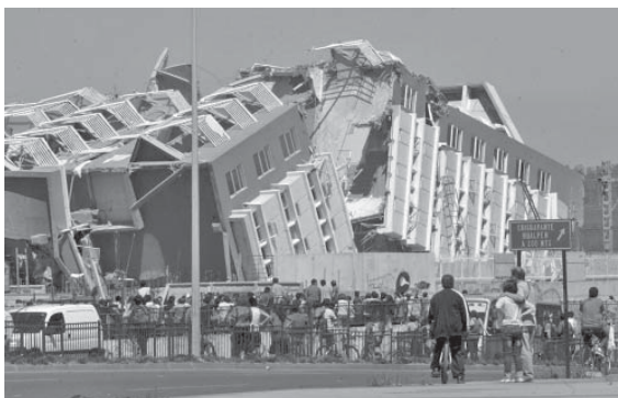
Рис. 1. Разрушенное сейсмостойкое здание в г. Консепсьон.
