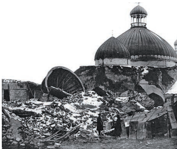
Рис. 2. Старейшая в Шамахе Джума мечеть после землетрясения 1902 г. (фотограф Ю. С. Зелинский). Fig. 2. The oldest mosque in Shamakhi, Juma mosque after the 1902 earthquake (taken by Yu. S. Zelinsky).
