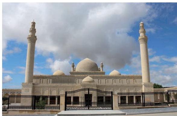
Рис. 3. Государственный историко-архитектурный памятник Джума мечеть в Шамахе после реставрации (2013 г.). Fig. 3. State historical and architectural monument Juma mosque in Shamakhi after restoration (2013).
