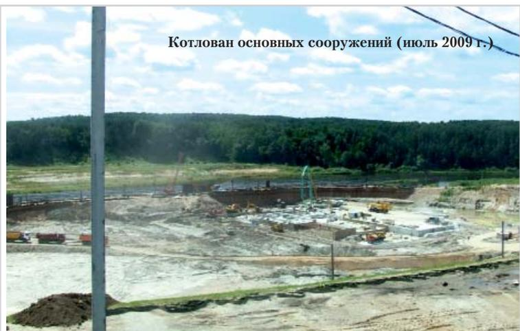
решения по водосливной плотине, по её гидромеханическому оборудованию, а так же частично и по зданию ГЭС. С учётом уточнённых геологических изысканий, приходилось разрабатывать некоторые конструктивные мероприятия в соответствии с геологическими условиями уже вскрытого котлована.
