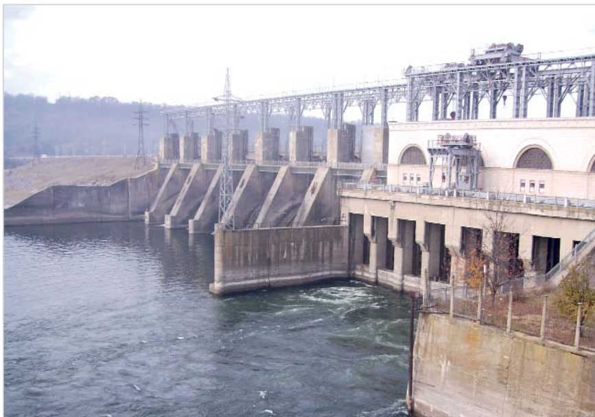
Дубоссарская ГЭС, введена в эксплуатацию в 1954 году
