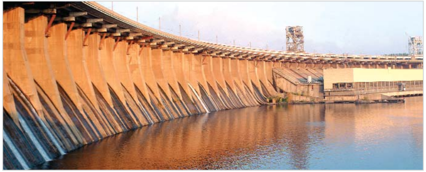
ДнепрОЭС-2, введена в эксплуатацию в 1981 году
