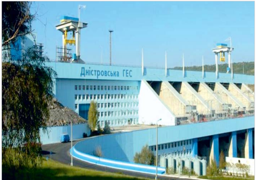
Днестровская ГЭС-1, введена в эксплуатацию 1983 году
