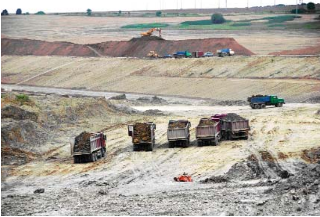
Рис. 6. Подготовка основания дна
