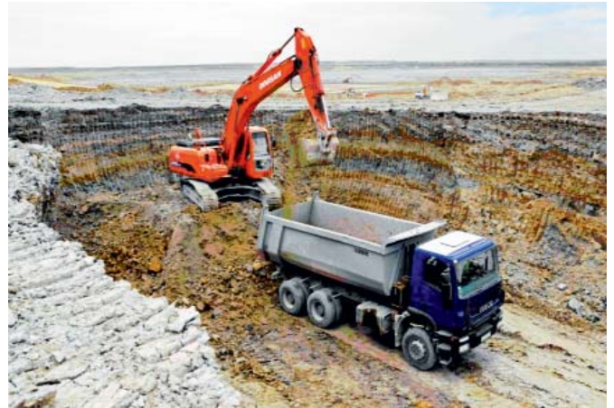
Рис. 7. Выемка грунтов
