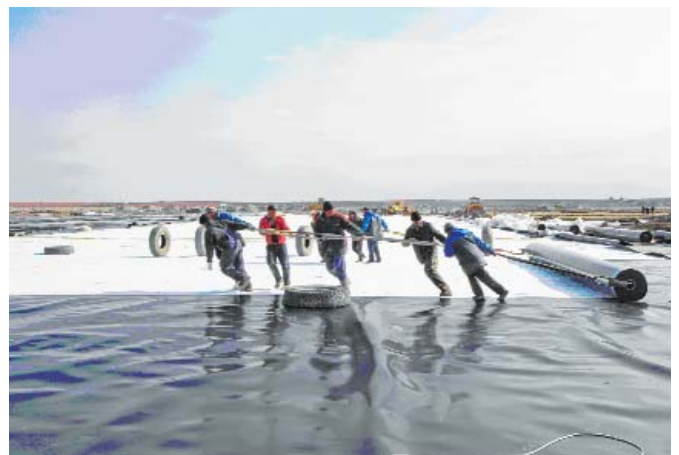
Рис. 9. Укладка геомембраны
