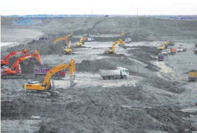
Рис. 12. Разбор временной дамбы
