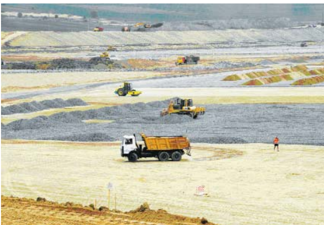
Рис. 10. Укладка песчано-гравийного грунта
