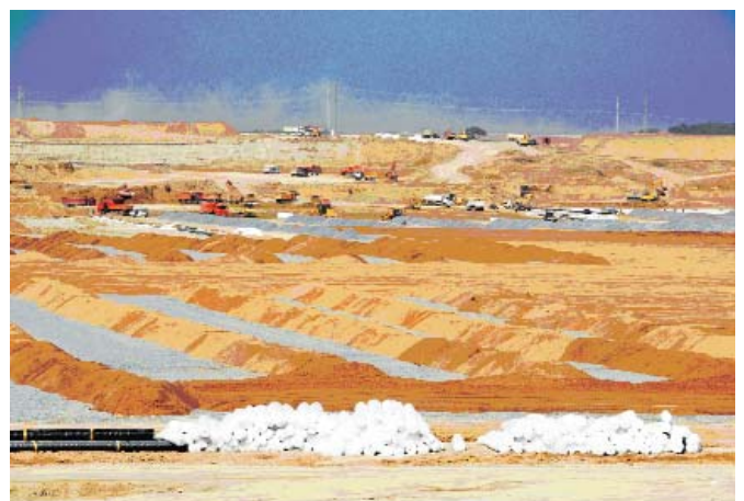
Рис. 11. Защитный слой из песка
