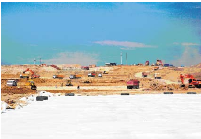
Рис. 8. Укладка геотекстиля
