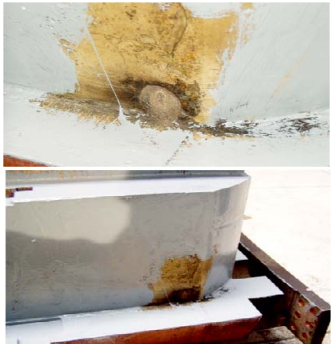
Рис. 1. Повреждение поясной изоляции полюса ротора ГД-1 Киевской ГАЭС
