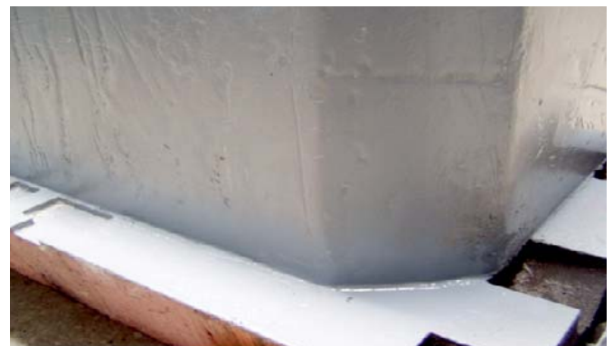
Рис. 1. Полюс ГД-1 Киевской ГАЭС после ремонта
