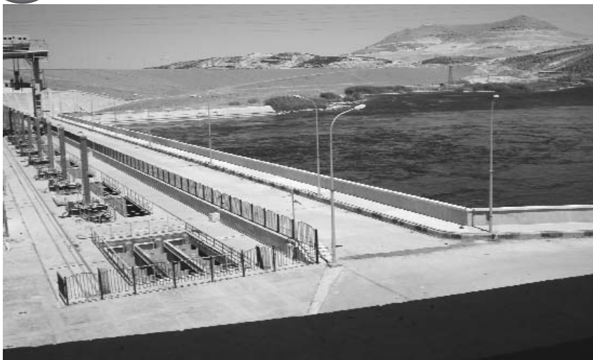
Рис. 4. Вид Тишрінського гідровузла з нижнього б'єфу
