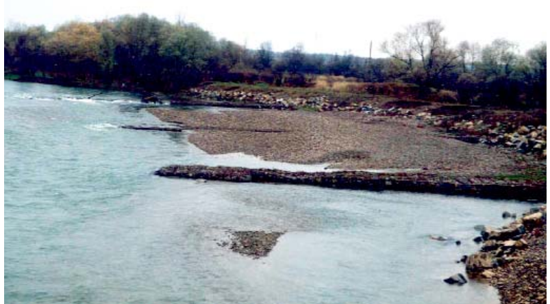
Рис. 9. Захист берега від розмиву на р. Лімниця
