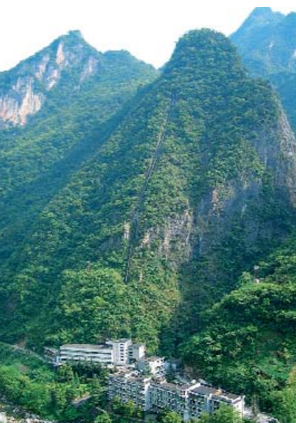
Китай (малая ГЭС Хоуцзыбао, вода поступает с горы по трубопроводу)
