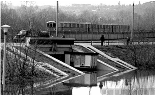
Рис. 6. Перехід під станцією метро "Гідропарк" під час паводку у квітні 1970 року ( http://www.unian.net/society/337986-kiev-potop-v-stile-retro-fot )
