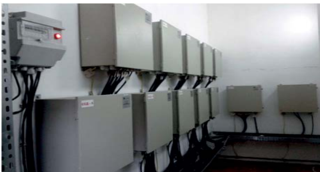
Рис. 2. Комутаційно-вимірювальний пункт (група локальних концентраторів) в технічному приміщенні
