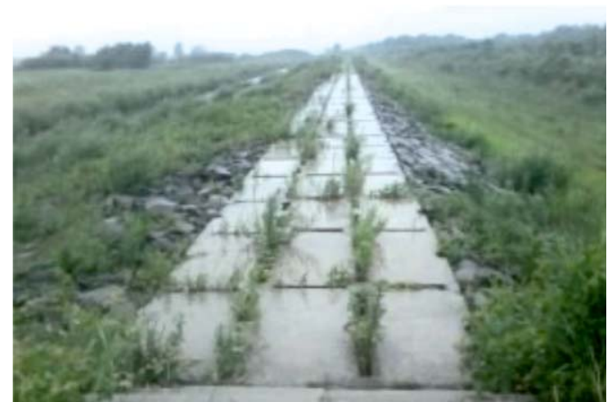
Рис. 4. Боковий автоматичний водозабір протипаводкової акумулюючої ємності "Чайковичі" на р. Дністер у Львівській обл. (реалізовано за рекомендаціями кафедри ГТБГ)
