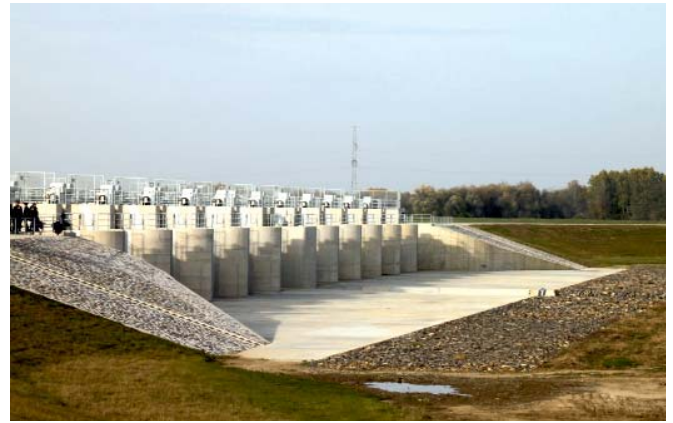
Рис. 2. Водозабірні споруда найбільшого протипаводкового акумулюючого польдера в середній Європі, Угорщина
