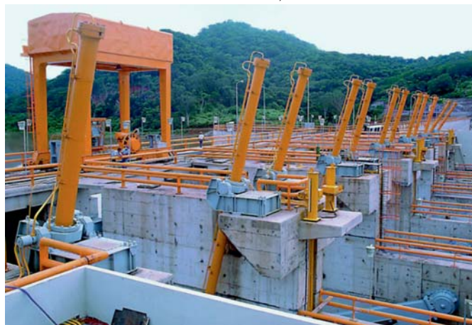
Рис. 10. Гидропривод водосброса, ГЭС Сан Рафаэль, Мексика
