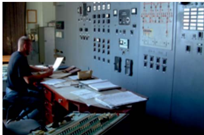
Рис. 2. Система керування станцією (Центральний пульта управління)
