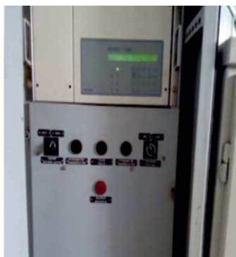
Рис. 3. Регулятор швидкості типу DIGIPID-1500
