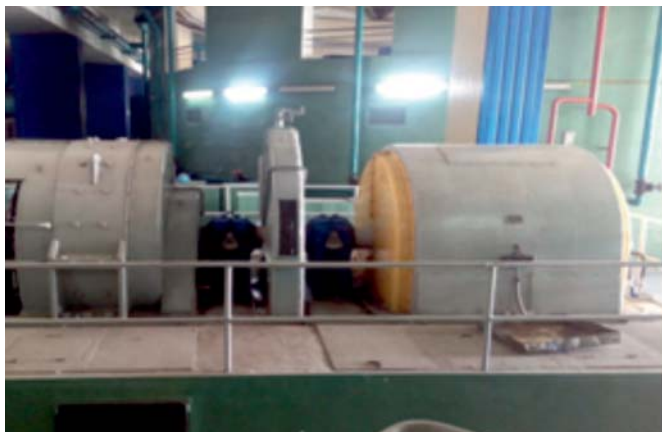
Рис. 1. Система машинного збудження блока ГЕС
