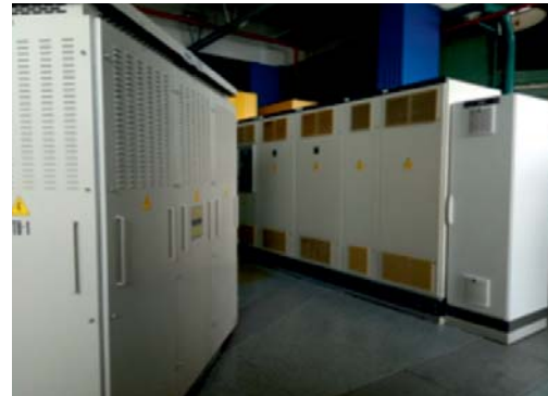
Рис. 4. Статична тиристорна система збудження UNITROL-P
