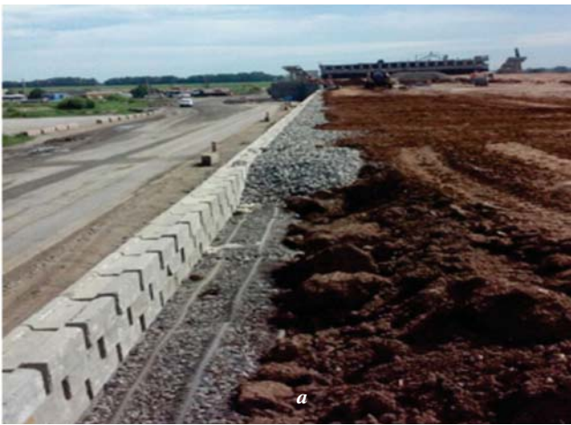
Рис. 1. Будівництво дворівневої транспортної розв'язки із застосуванням системи Tensar Wall на перетині автодорог Н-31 «Дніпро-Решетилівка» (а) та М-22 «Полтава-Олександрія» (б)
