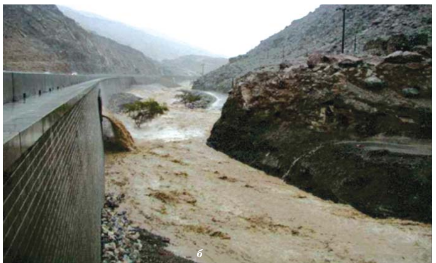
Рис. 2. Підпірна стінка із застосуванням системи Tensar TW1 на швидкісній автомагістралі в Тайвані (Dibba, UAE.): а – дренажні отвори в підпірній стінці; б – під час проходження повені
