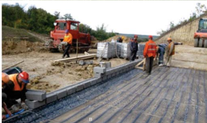
Рис. 3. Зведення підпірної стінки на 92 км автодороги «Київ-Одеса»: а – загальний вид на схил; б – випір ґрунту на автодорозі; в – влаштування георешітки; г – влаштування підпірної стінки з георешіток
