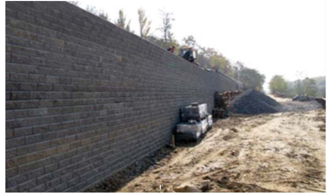
Рис. 3. Зведення підпірної стінки на 92 км автодороги «Київ-Одеса»: а – загальний вид на схил; б – випір ґрунту на автодорозі; в – влаштування георешітки; г – влаштування підпірної стінки з георешіток
