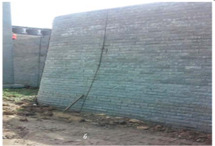
Рис. 1. Будівництво дворівневої транспортної розв'язки із застосуванням системи Tensar Wall на перетині автодорог Н-31 «Дніпро-Решетилівка» (а) та М-22 «Полтава-Олександрія» (б)
