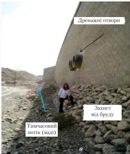
Рис. 2. Підпірна стінка із застосуванням системи Tensar TW1 на швидкісній автомагістралі в Тайвані (Dibba, UAE.): а – дренажні отвори в підпірній стінці; б – під час проходження повені
