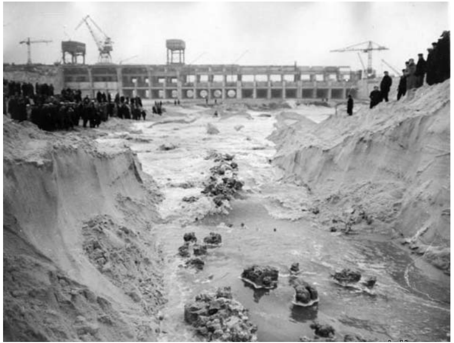
Київська ГЕС перед затопленням котловану
