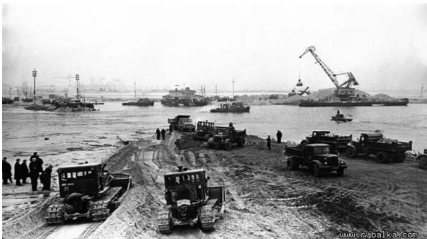
Перекриття русла Дніпра під час будівництва Київської ГЕС
