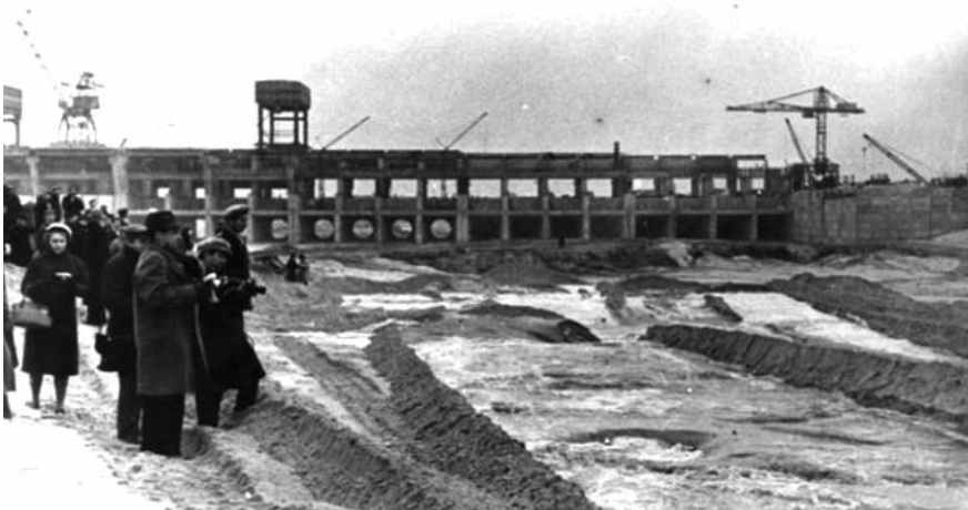
Панорама затоплення котловану Київської ГЕС
