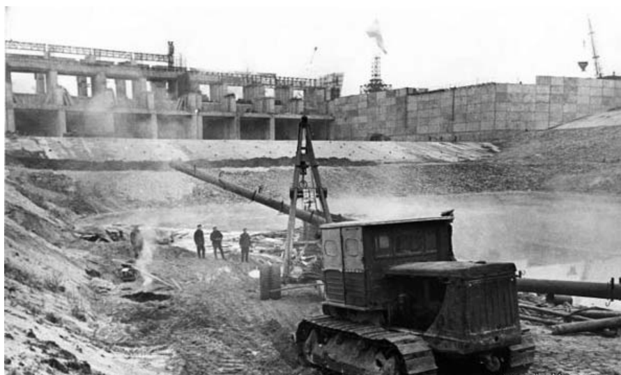
Загальний вигляд будівництва ГЕС
