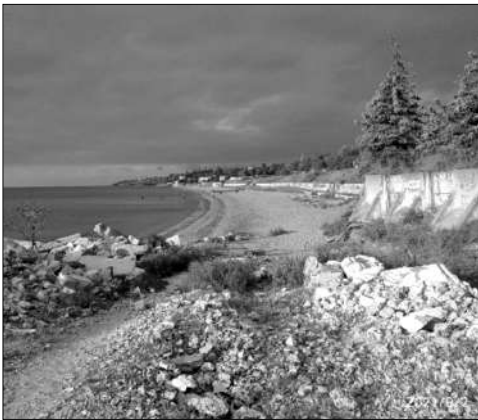
Рис. 4. Залишки зруйнованих дачних будівель в районі пляжу Райдуга (м. Чорноморськ)
