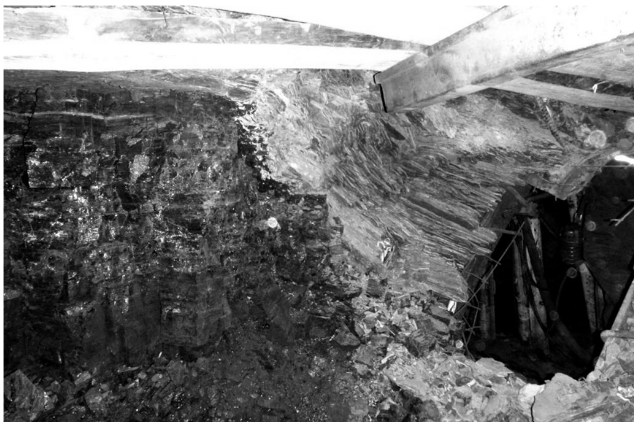
Рис. 2 - Состояние горного массива в бортах выработки в условиях шахты «Степная»
