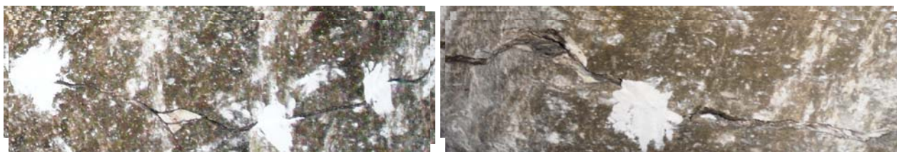
а) – порядка 5 мм в 2010 г.; б) – порядка 10 мм в 2012 г. Рисунок 6 – Увеличение раскрытия базовой трещины со временем на участке сопряжения между 7 сбойкой и 31 камерой VII панели
