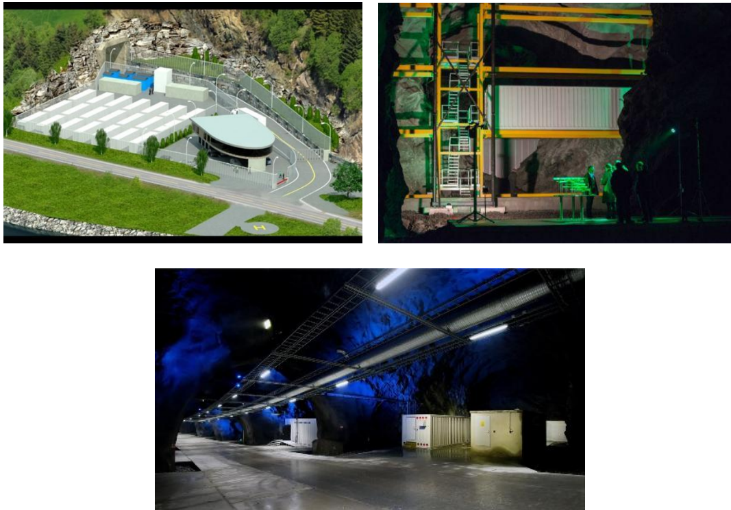
Рисунок 7 – Дата-центр Lefdal Mine Datacenter
