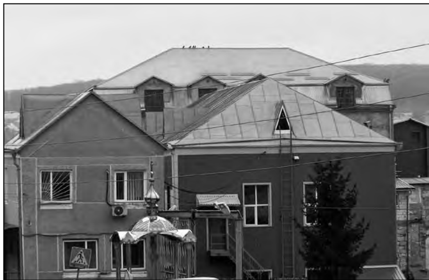
Іл. 5. Будови, що закривають синагогу в Збаражжі з північної сторони. Фото Т. Федорів, 14 березня 2017 р.
