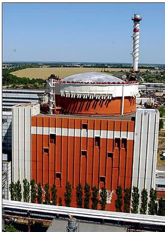
Рис. 1. Загальний вигляд реакторного відділення ВВЕР-1000 Южно-Української АЕС із ЗО
