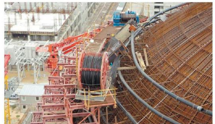
Рис. 1. Монтаж каналоутворювачів захисної оболонки реакторного відділення АЕС
