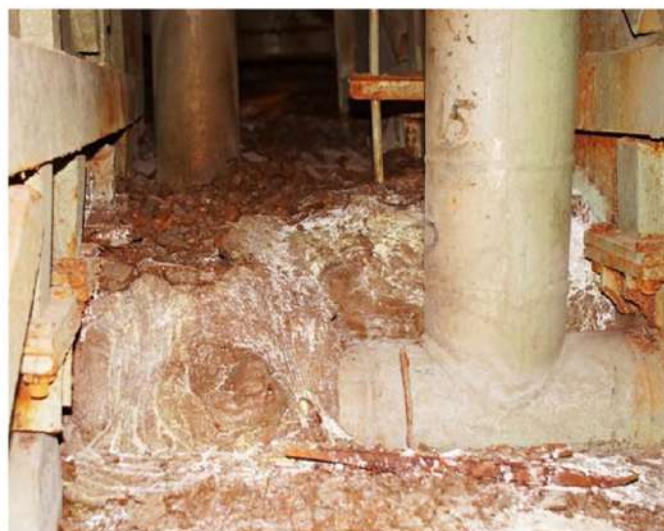
Рис. 1. Лавообразные топливосодержащие массы в помещении 210/7
