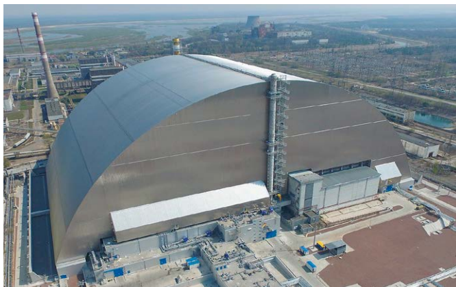
Рис. 1. Загальний вигляд комплексу НБК-ОУ
