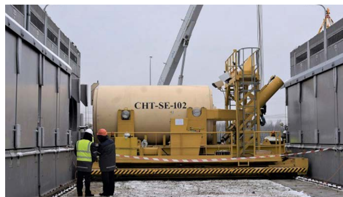
Рис. 5. Розміщення першого контейнеру з відпрацьованим ядерним паливом у сховище СВЯП-2
