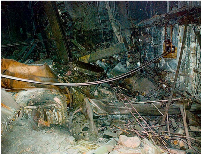
Рис. 6. Приміщення 1005/2 (операторська РЗМ), графітові блоки і ФАЗ
