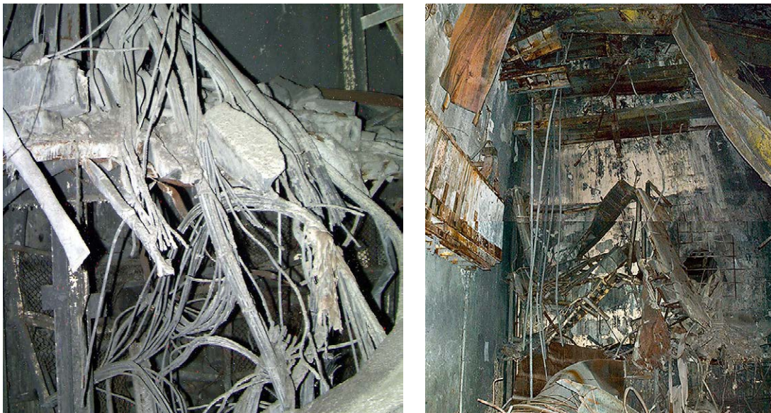
Рис. 3. Вузол розвішування «свіжого» палива після аварії (а), зруйновані «свіжі» ТВК (б)
